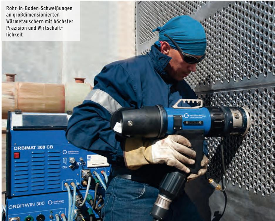
Rohr-in-Boden-Schweißungen an großdimensionierten Wärmetauschern mit höchster Präzision und Wirtschaftlichkeit
